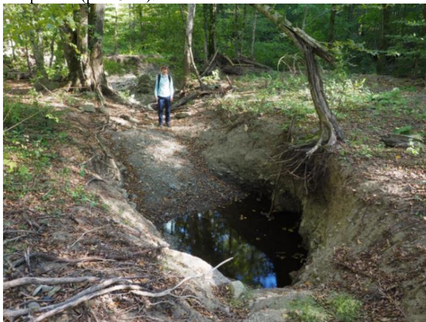
Рисунок 3.11 - Эвормионный котел и следы активной донной эрозии на р. Синявка
