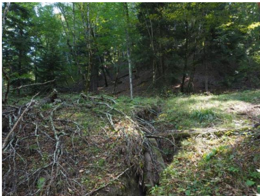
Рисунок 3.13 - Промоина на старой лесовозной дороге в юго-восточной части создаваемой ООПТ
