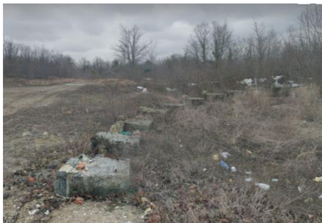
Рисунок 6.3 – Кольцевой фундамент на территории участка 23:33:0605003:271 (фотография из открытого источника)
