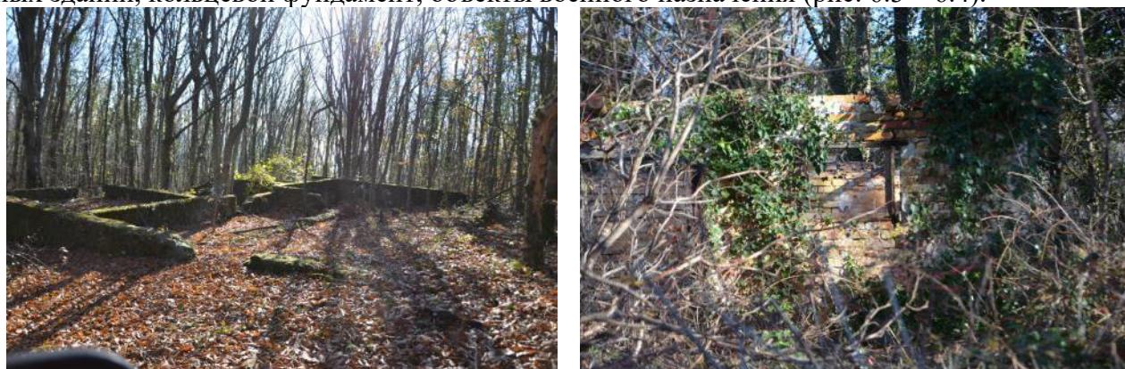
Рисунок 6.2 – Разрушенные здания в границах участка 23:33:0605003:271
