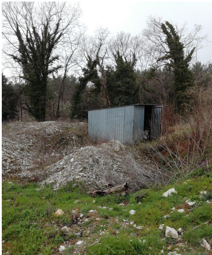
«Участок с признаками несанкционированного размещения насыпного грунта и временного сооружения на территории заказника «Агрыйский»»
