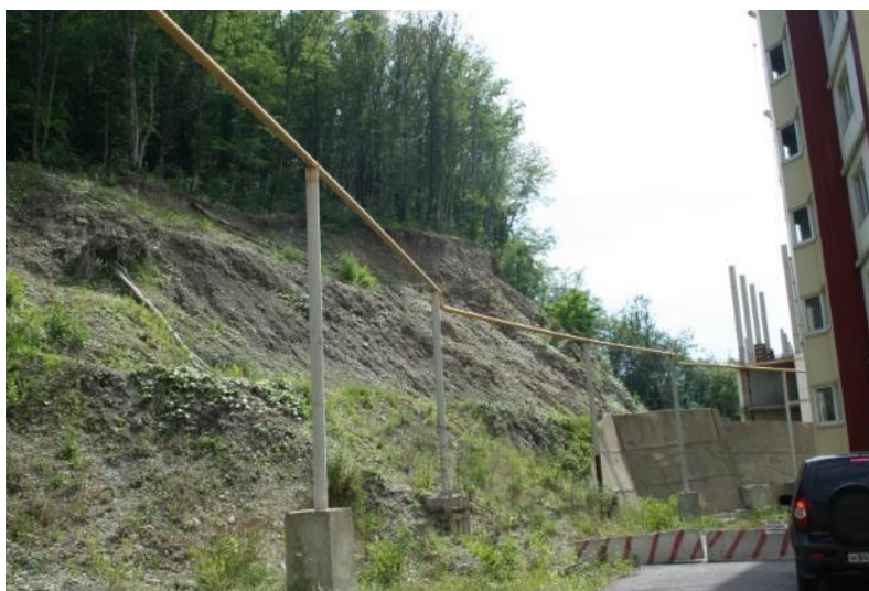
Рисунок 6.1 – Строительство многоквартирных домов в районе северо-западной границы обследуемой ООПТ
